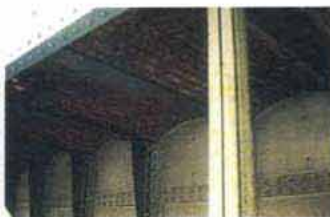
10. パリの地下鉄が地上に出て高架になっている所(アーチは全て煉瓦で作られる)
