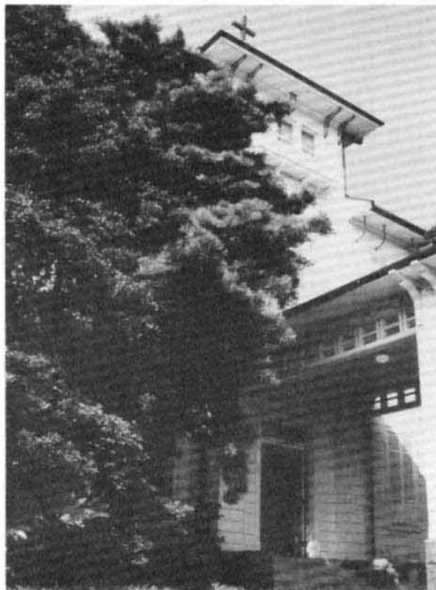
【旧東伏見宮別邸 外観】
