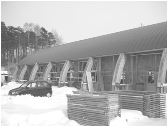
体験学習できる体育館（工事中）
