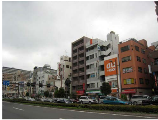
既存のよくある雑居ビル群
