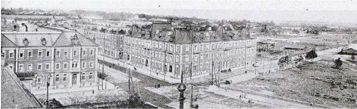
東京市役所の建物上から三菱1号館を見ている。(明治44年) 馬場先通りの一丁倫敦の裏手には空き地が広がっており、三菱以外に何も無い、まさに三菱村といった風景。
