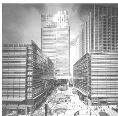
働くこと。住まうこと。遊ぶこと。憩うこと。 そのすべてが一体となった複合都市「東京ミッドタウン」(平成 19 年開業)
