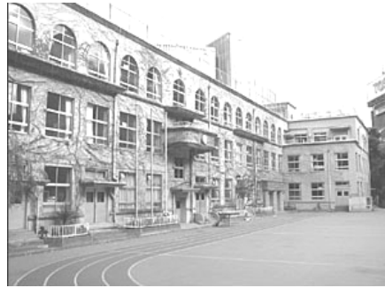
泰明小学校（昭和 4 年）
