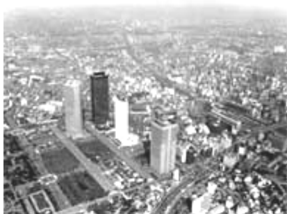
超高層ビルの建設が始まった新宿副都心 (昭和 49 年頃)
