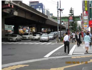
高速道路は、このように自動車道路の上だけでなく、歩道の上もクロスしていく
