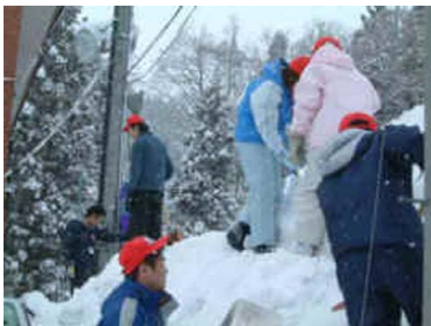
図 4-6 雪下ろし作業 (提供：三田育雄)
