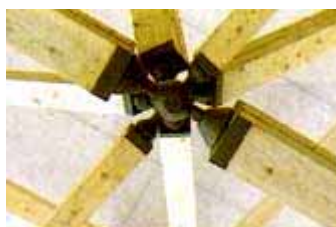
天井ジョイント部分(上の2点は小国町HPより)
