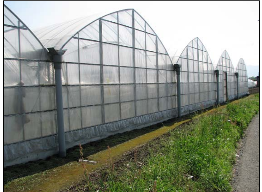
ビニールハウスの雨水浸透施設
