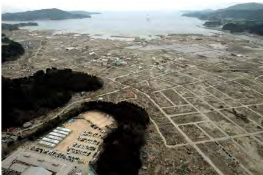
【市街地の被災状況】
