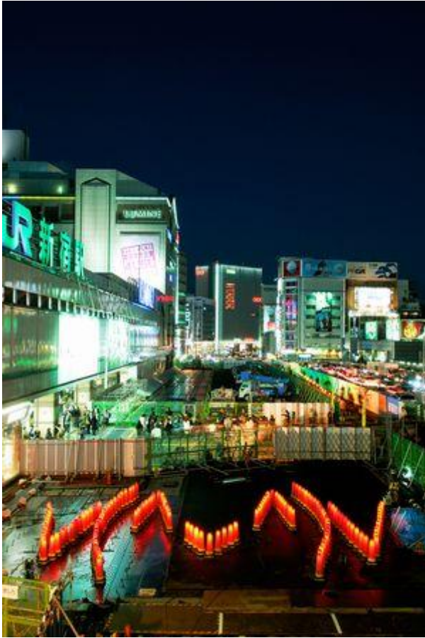
JR新宿駅南口の跨線橋架け替え工事の現場(2007年) photo: momoko japan
